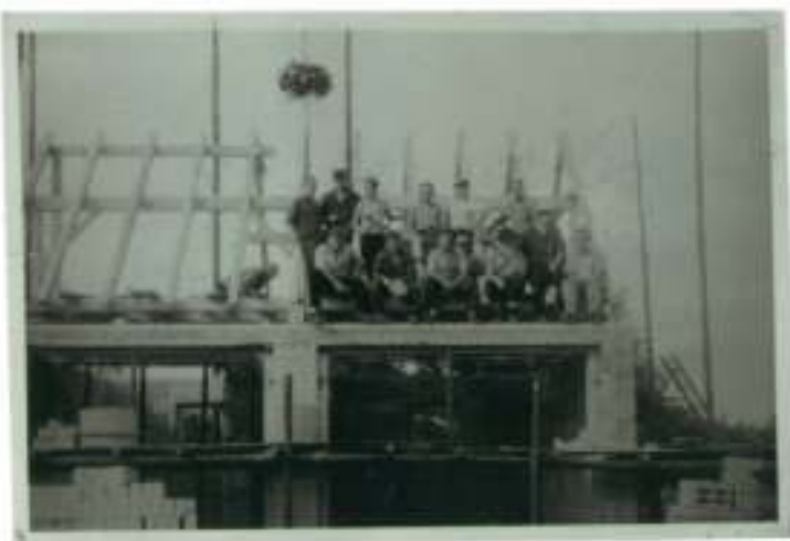
Richtfest des neuen Geräte- hauses, 1962
