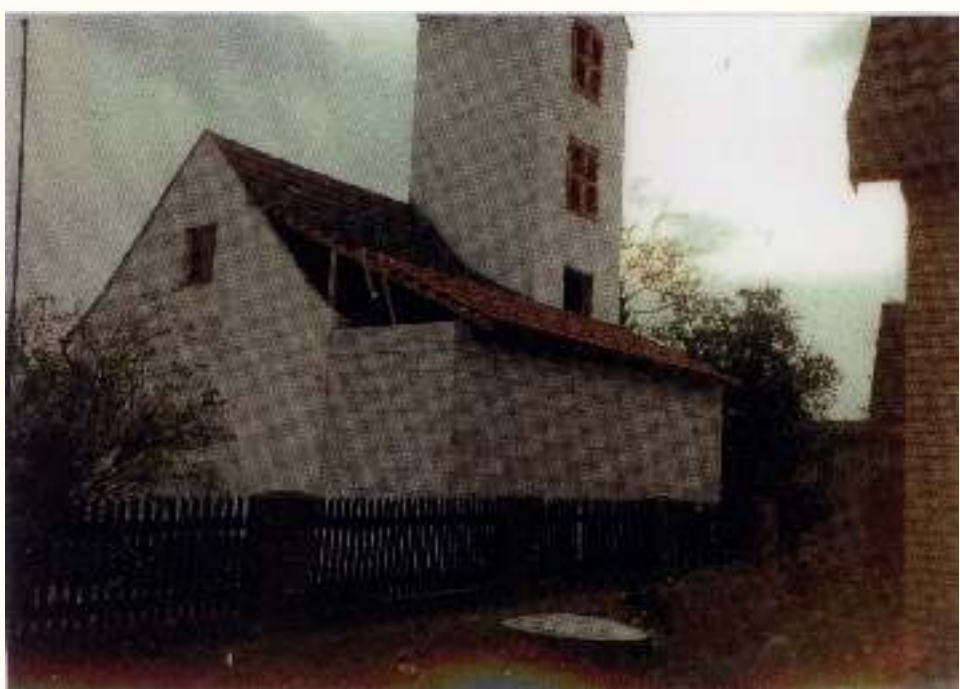
Erweiterung des Geräte- hauses für das neue Fahrzeug, 1994
