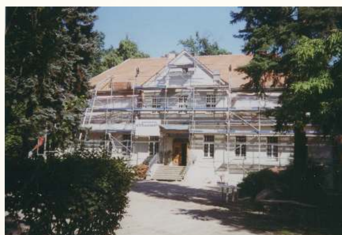
Neueindeckung des Daches, 2002
