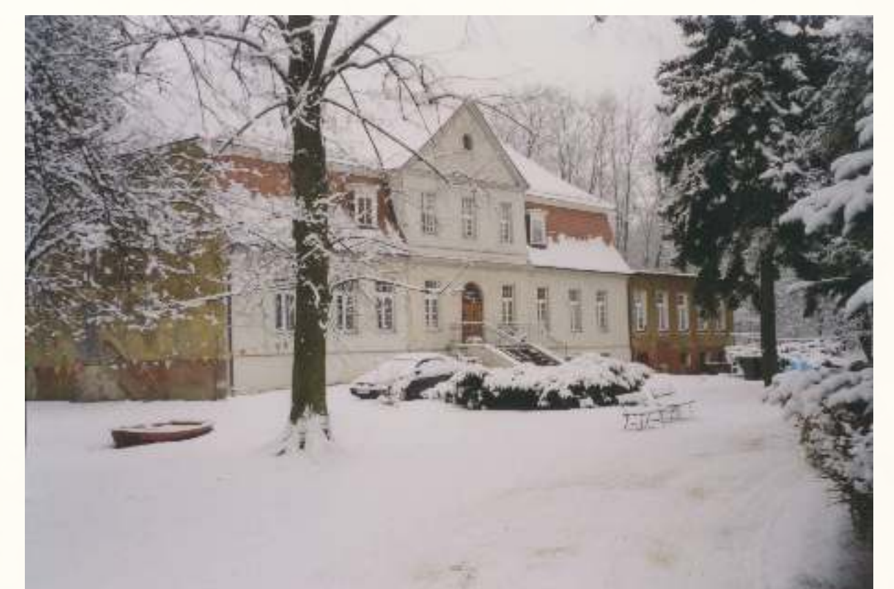
Nach der Sanierung im Winter 2003
